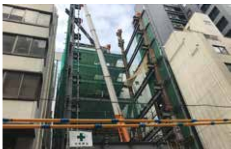
鉄骨建方施工状況
