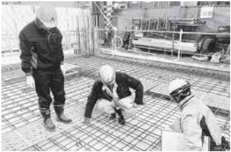
日本建設が進めるススキノのホテル現場内。繁華街で安全に配慮しながらホテル建設が進む
